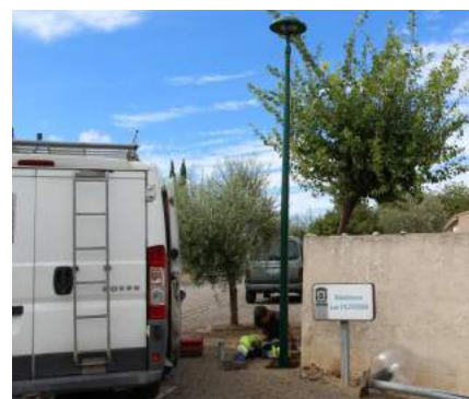
Rénovation de l'éclairage
