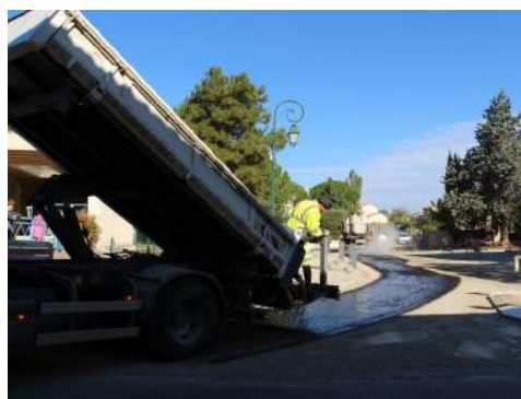
Goudronnage et réfection des trottoirs
