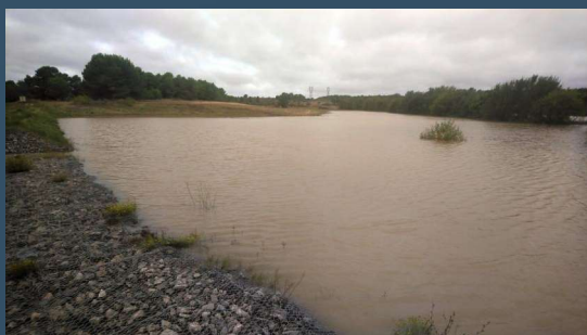
Le bassin de rétention, le 15/10/2018
