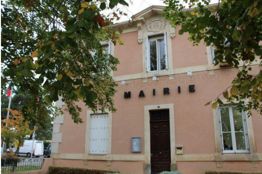
Le chantier de rénovation de la Mairie est en cours
