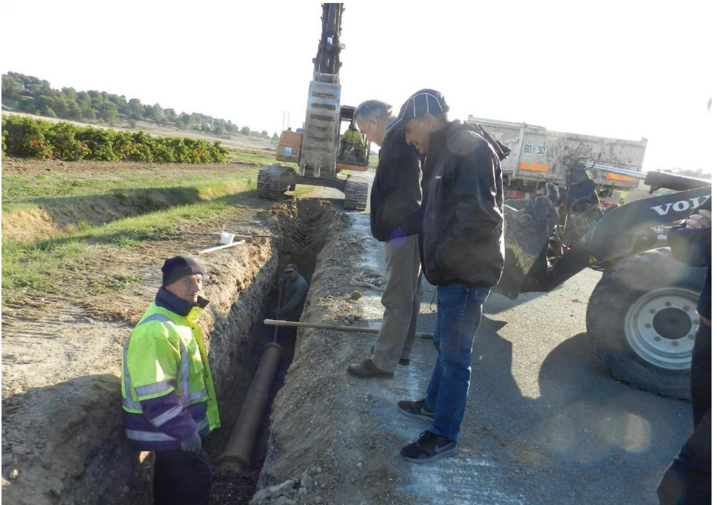
Suppression de la station d'épuration et raccordement à Trèbes en décembre 2015
