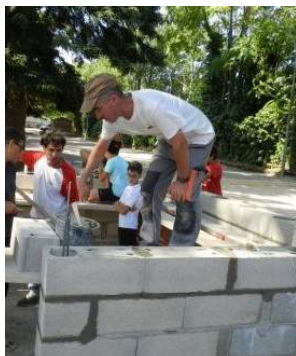
Dimitri Durand lors de la construction du barbecue dans le parc municipal
